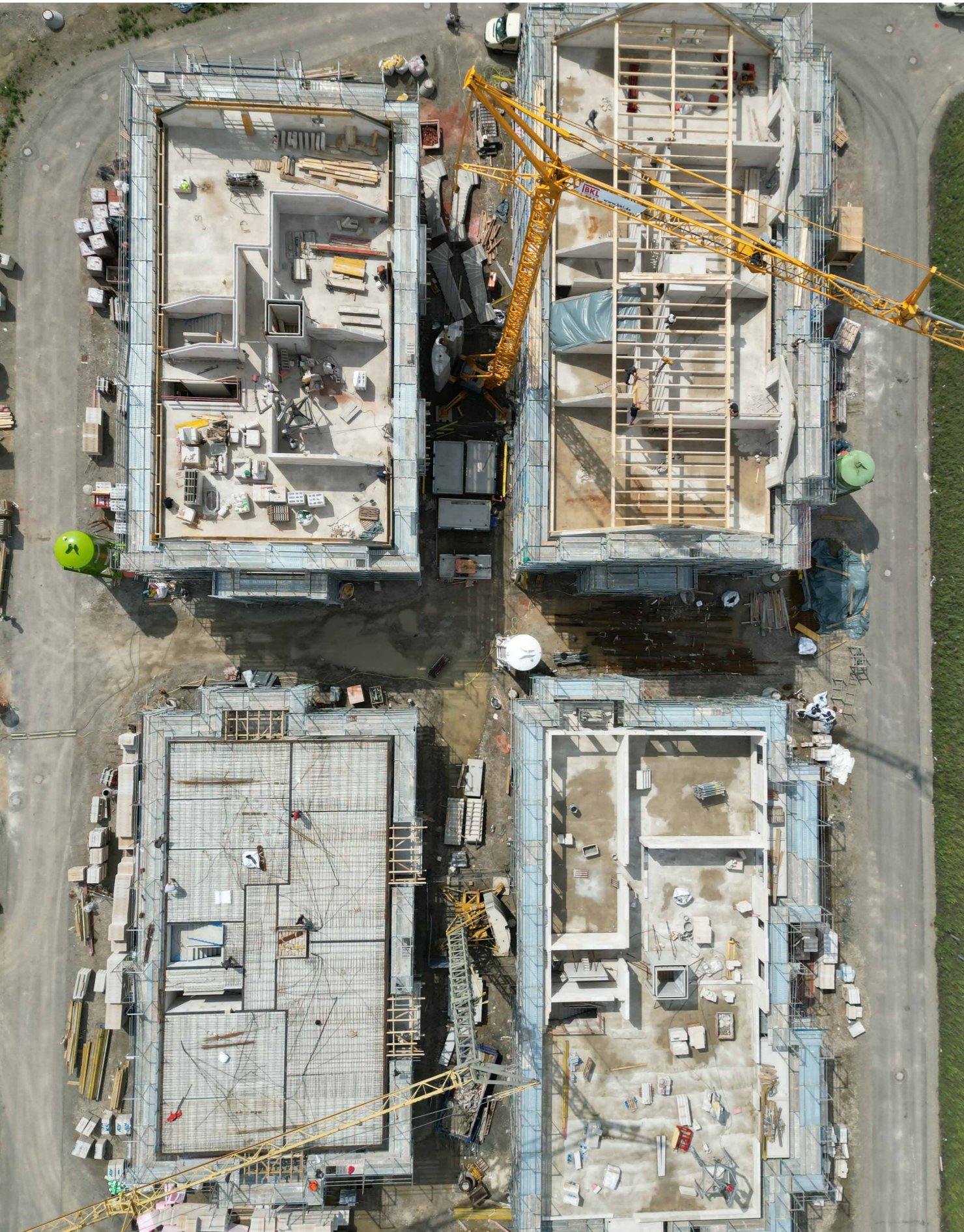
Baustelle Luhbachau Juli 2025
