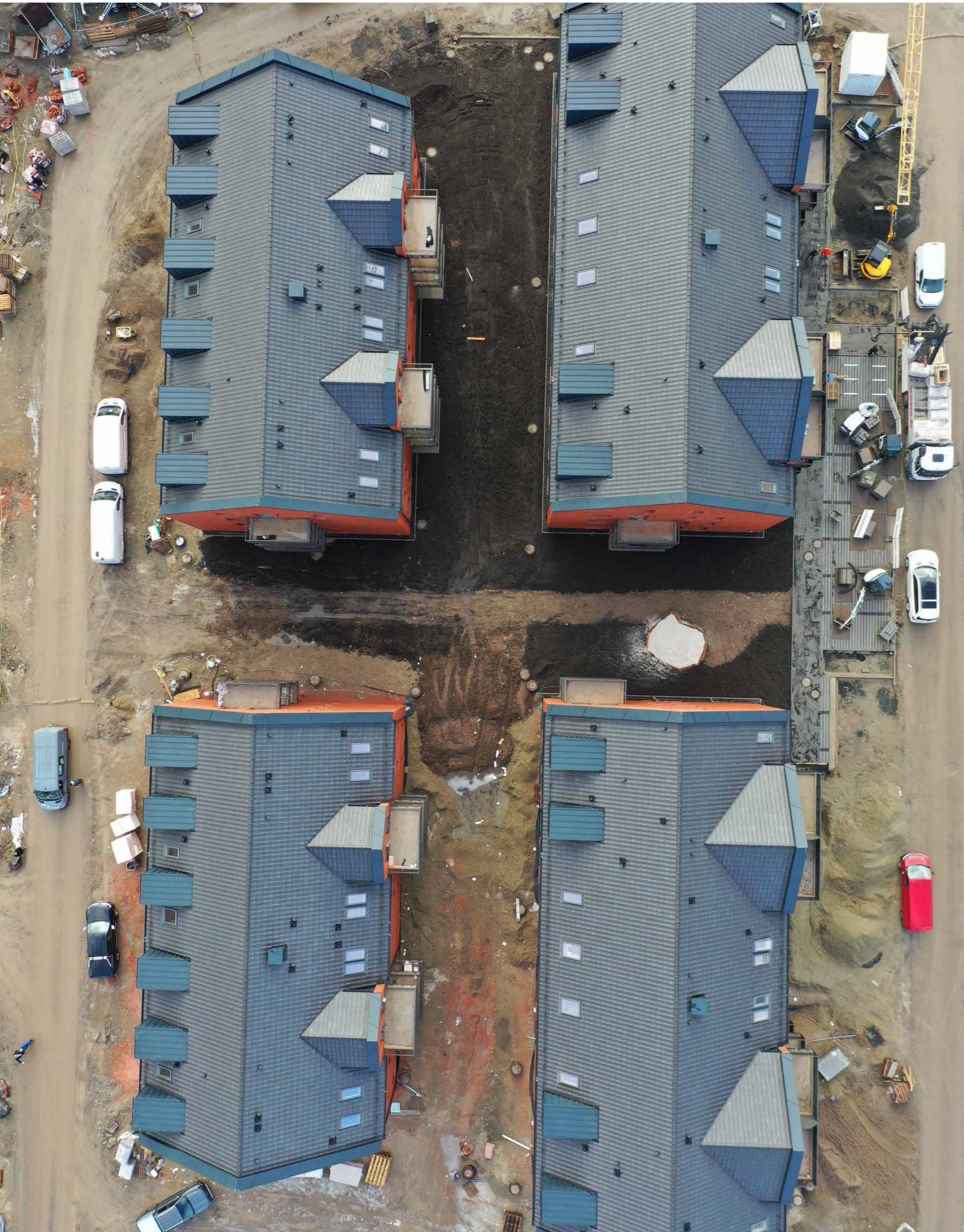
Baustelle Luhbachau Dezember 2025
