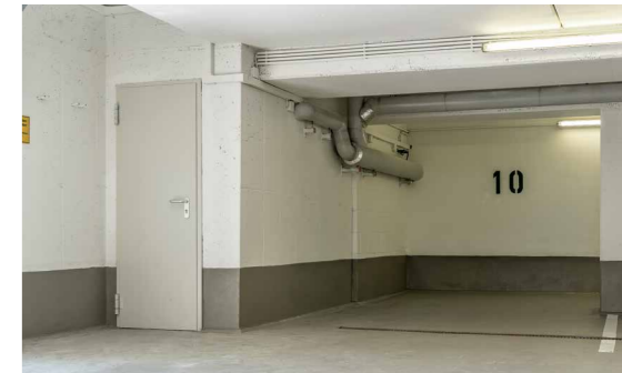
Tiefgaragen-Sanierung Im Großen Feld (vorher)
