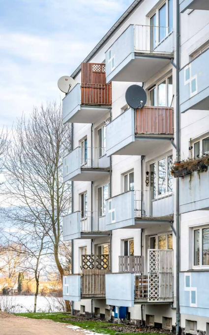
Laufende Balkon-Modernisierung in der Färberstraße (vorher)
