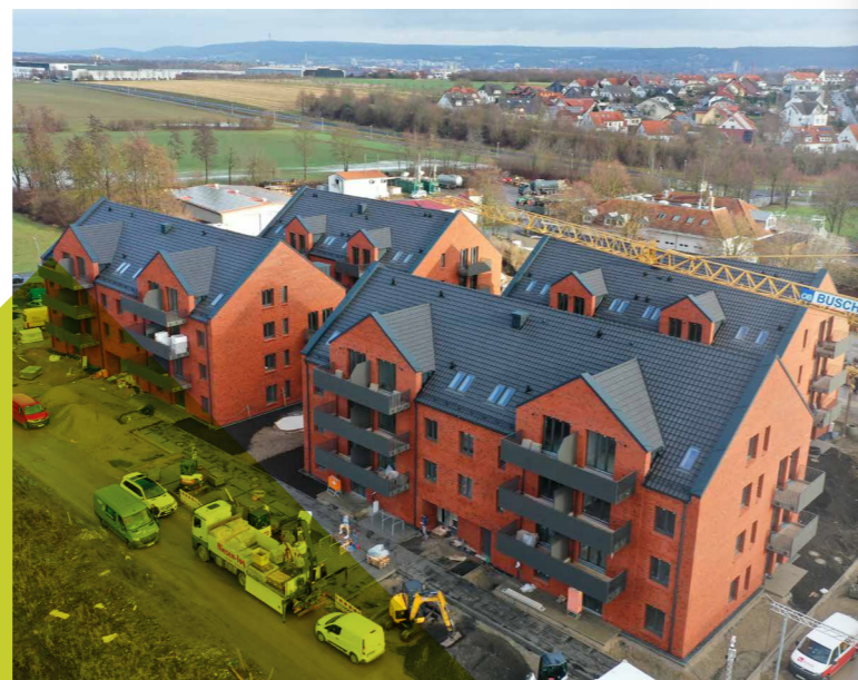
Die fertiggestellten Gebäude Ende 2025
