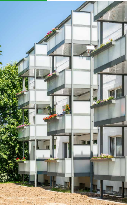
Laufende Balkon-Modernisierung in der Färberstraße (nachher)
