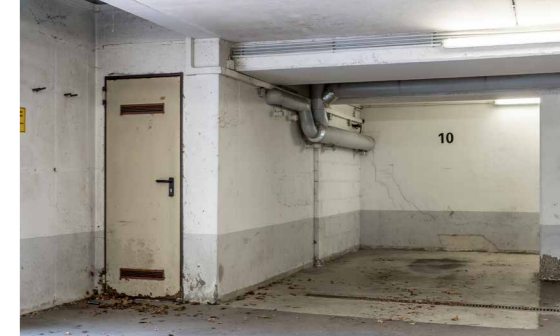
Tiefgaragen-Sanierung Im Großen Feld (nachher)
