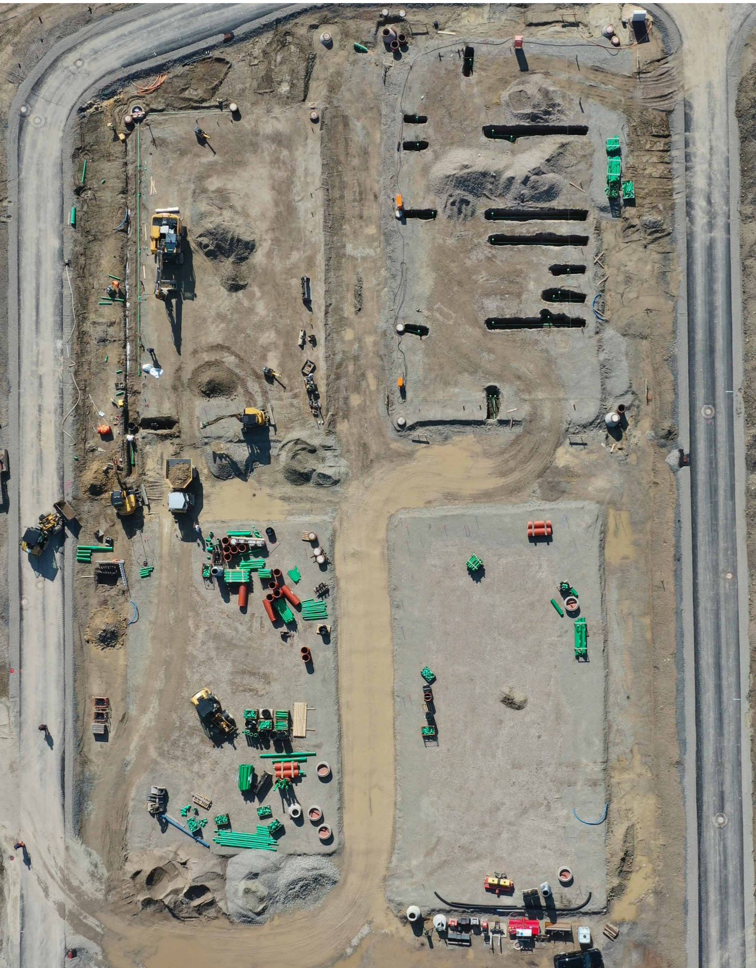
Baustelle Luhbachau März 2025
