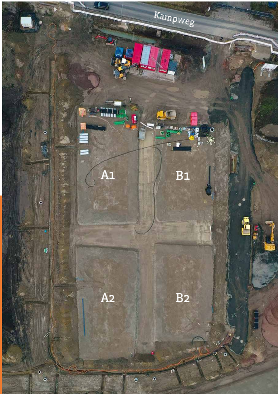
Die Abgrenzungen der Baufelder unserer Gebäude im Februar 2025
